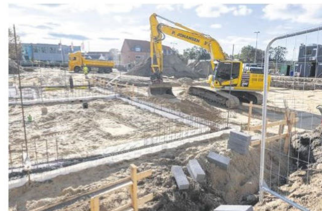
Et stort byggeri er gået i gang.
