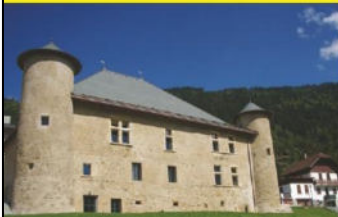
Maison Forte de Hautetour, Saint-Gervais
